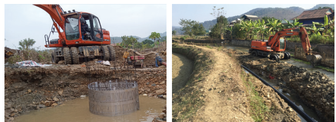
Hình 9. Thi công mô hình GTNM.
